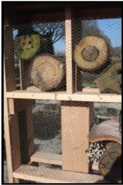
Het in aanbouw zijde insectenhotel
